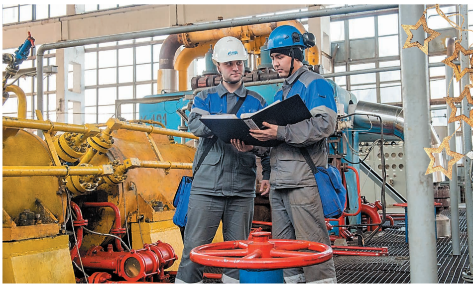
На производстве аммиака выполнена модернизация компрессора К-401
