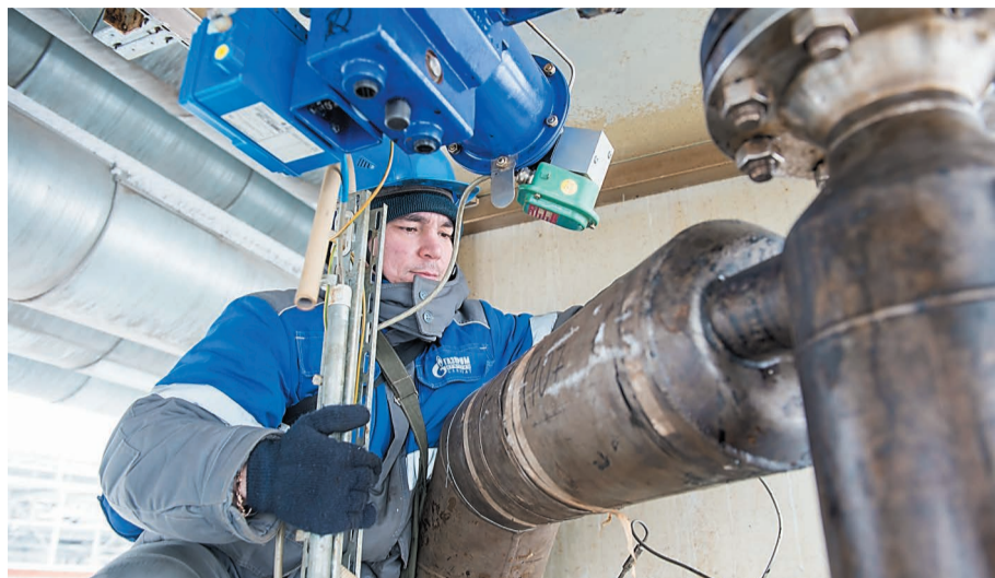
Монтируются расходчики на узле налива готовой продукции
