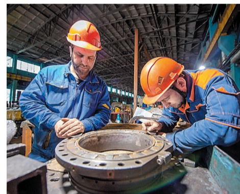
Ремонт вкладышей уплотнений генератора ст. № 1
