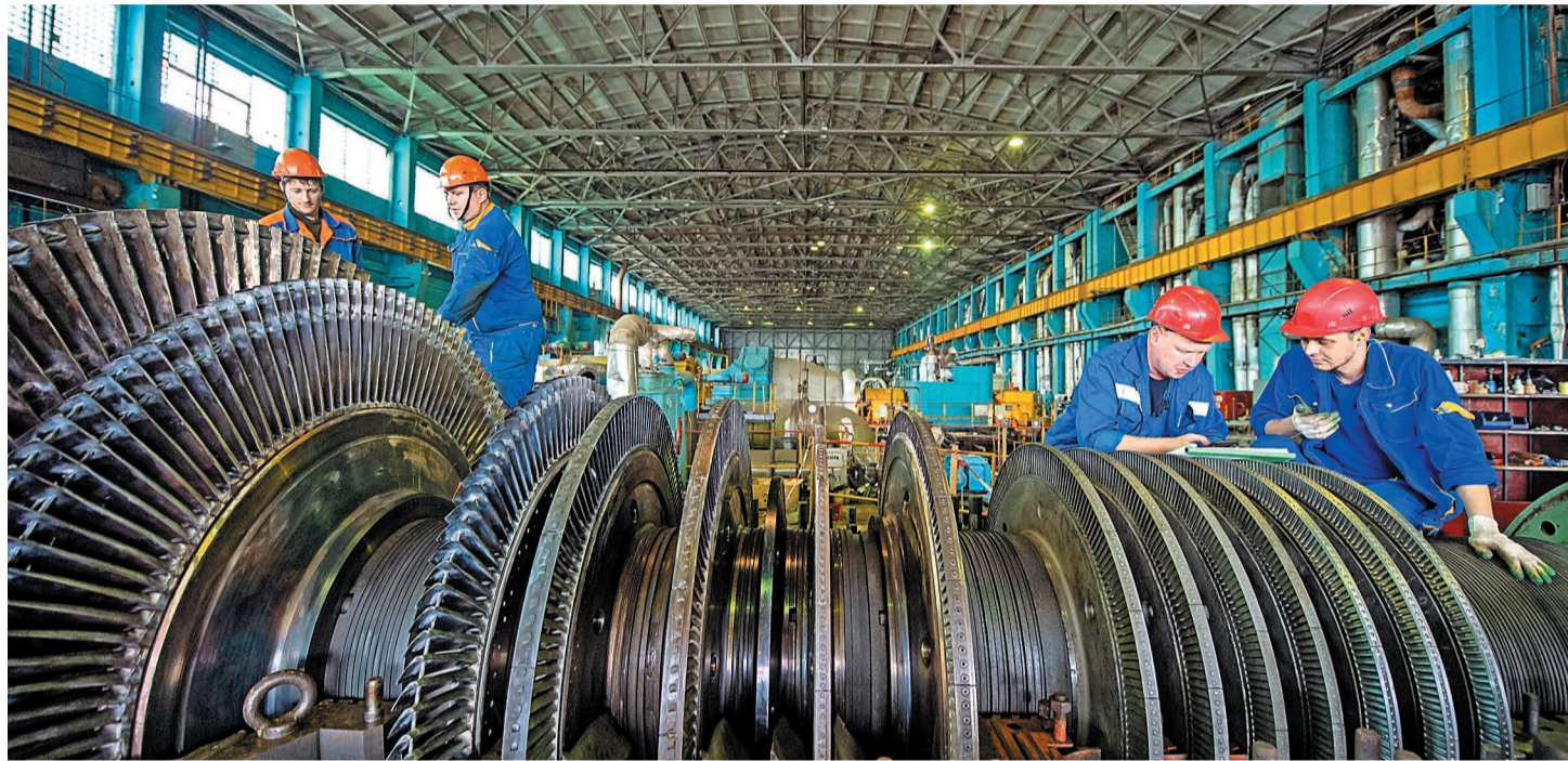
Капитальный ремонт проточной части турбогенератора ст. № 1
