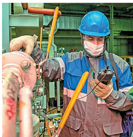
Ведется ультразвуковая толщинометрия трубопровода
