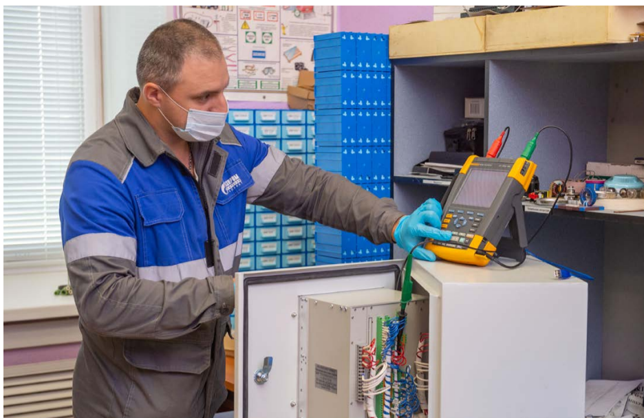
Подготовка к монтажу комплекса БАРВ происходит в электротехнической лаборатории УГЭ
