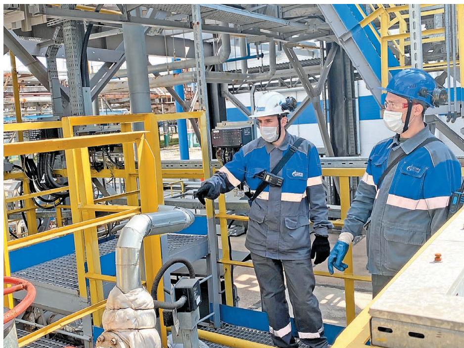
Персонал установки обсуждает подготовительные мероприятия накануне капитального ремонта
