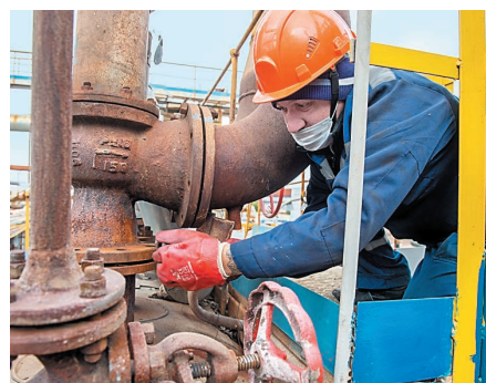
Демонтаж пружинно-предохранительного клапана на энерготехнологическом котле
