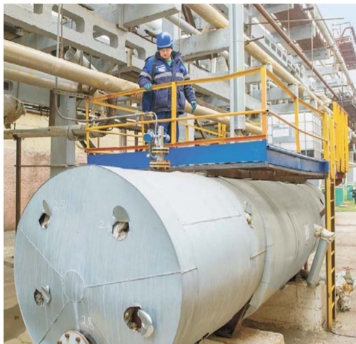
Емкость поз. Е-311 для приготовления раствора аммиачной воды
