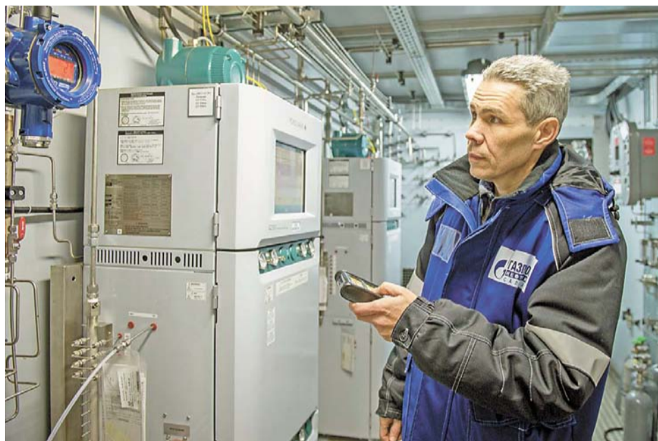
Приборист газового анализа Игорь Михайлов производил наладку хроматографов перед их пуском
