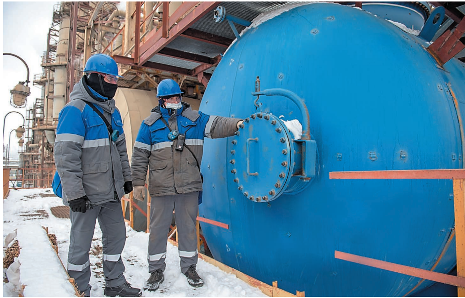
Продолжается реализация проекта по замене деаэратора
