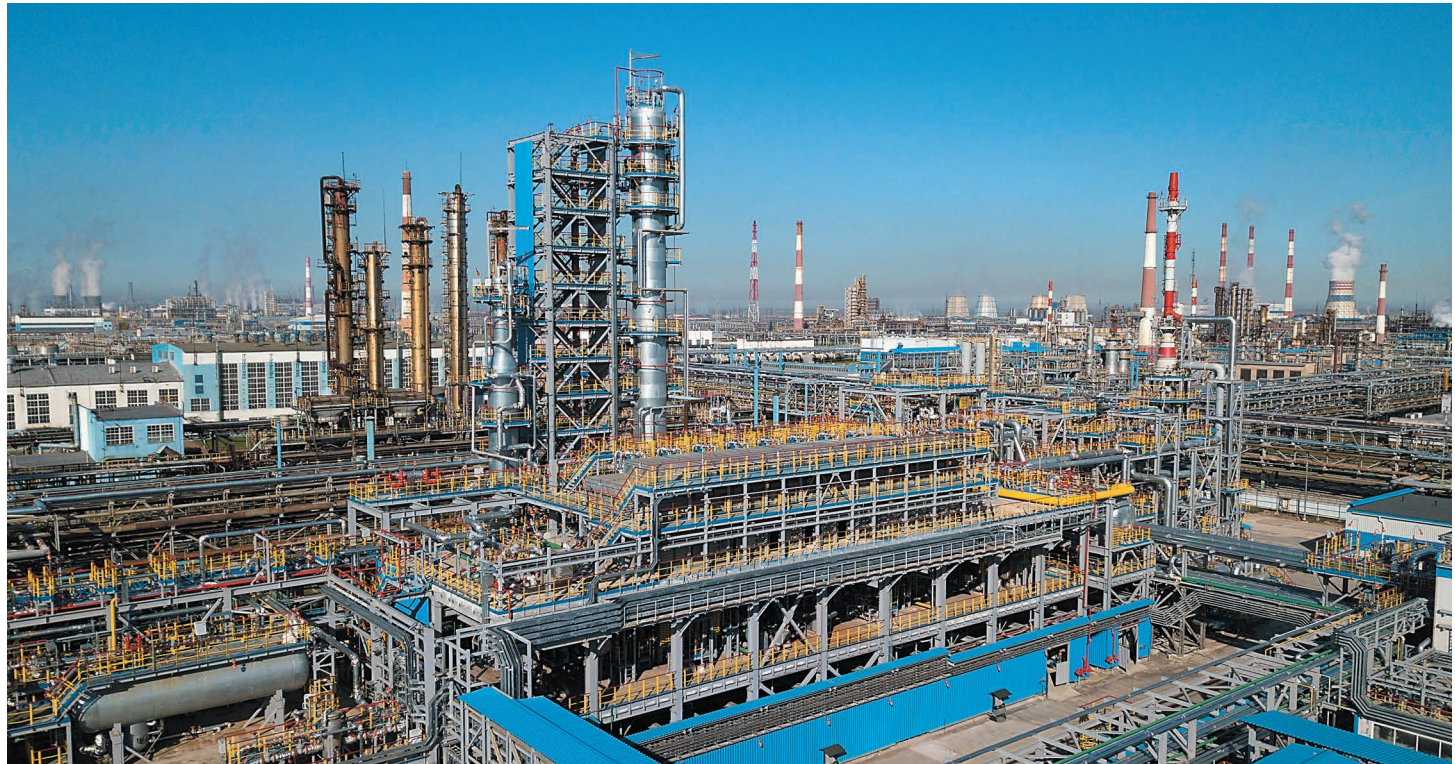
Объекты строящегося комплекса каталитического крекинга
