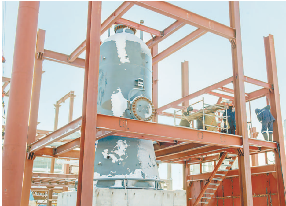
Монтаж реактора конверсии P-104. Вес аппарата составляет 17 тонн, диаметр – 2,5 метра, высота – 6 метров. Оборудование предназначено для конверсии остаточного угарного газа (СО) на медном катализаторе до продуктового водорода и углекислого газа
