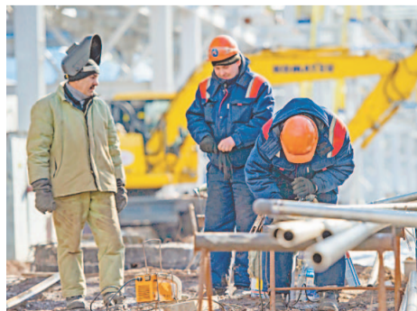
На стройплощадке задействовано почти 900 человек
