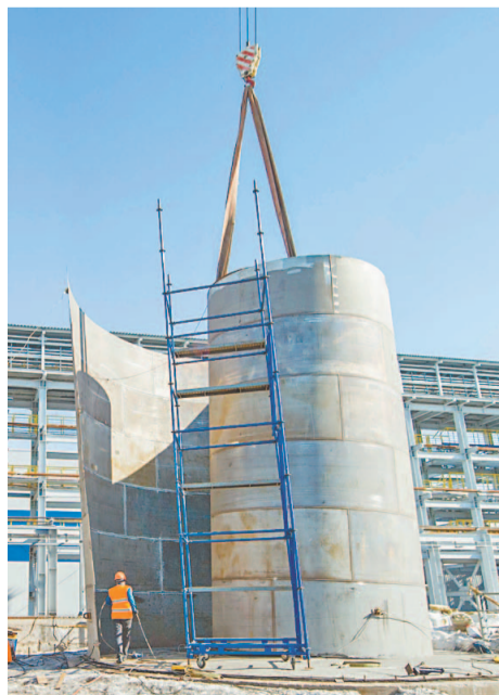
В товарно-сырьевом парке идет монтаж резервуаров
