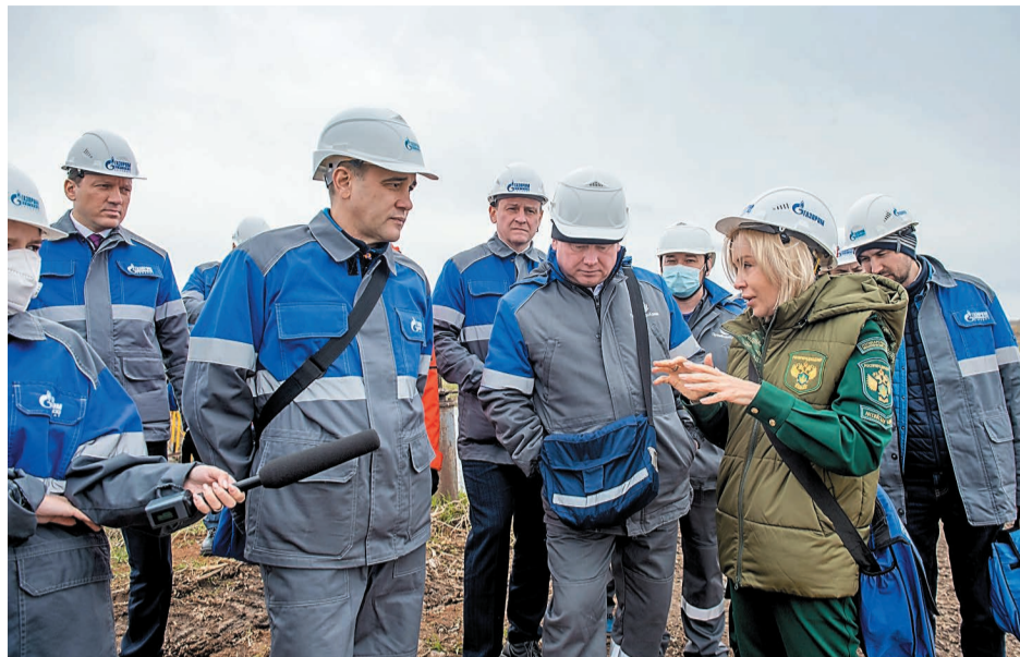
Руководитель Росприроднадзора ознакомилась с ходом реконструкции очистных сооружений компании
