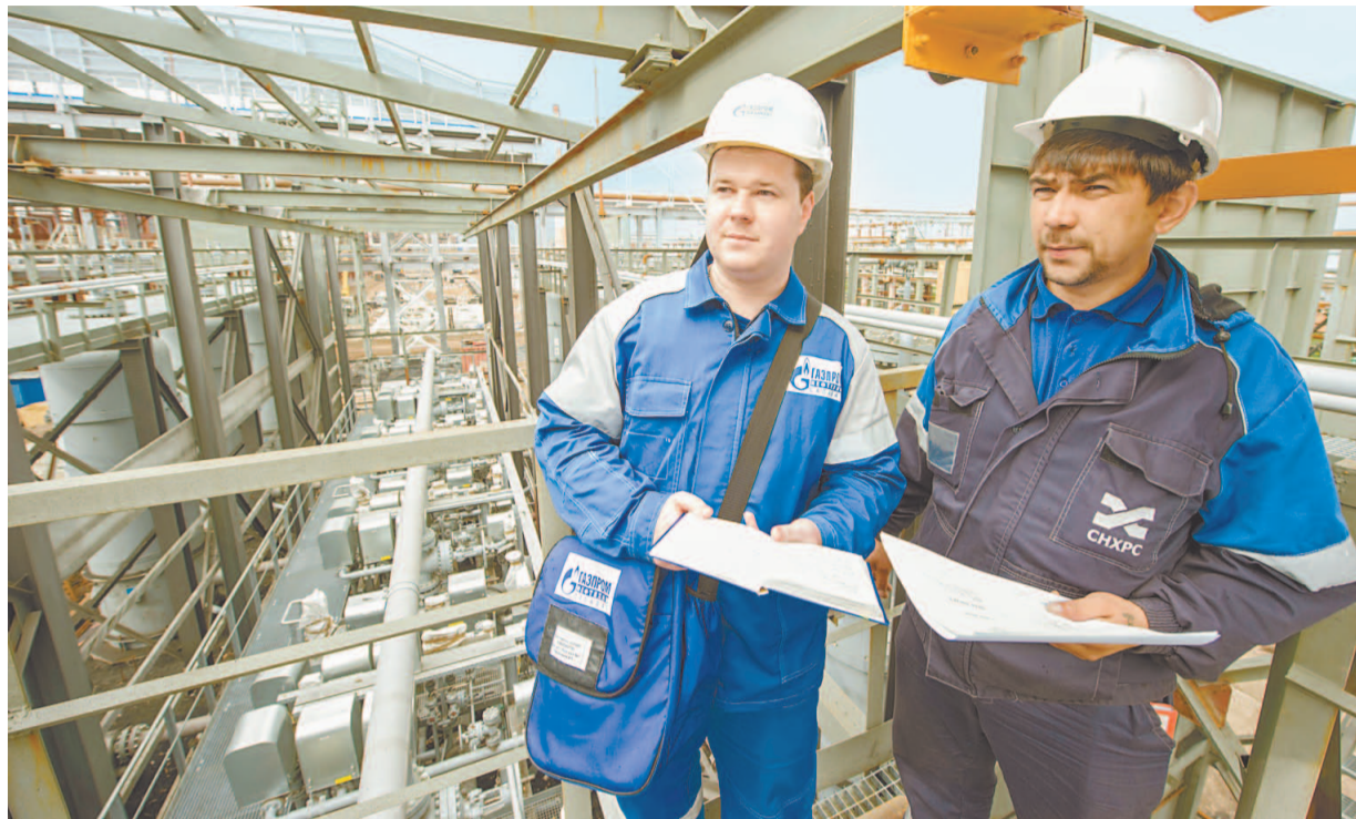
Начальник установки КЦА Виталий Герасимов (слева) беседует с подрядчиком на возведенных металлоконструкциях блока короткоциклового адсорбции
