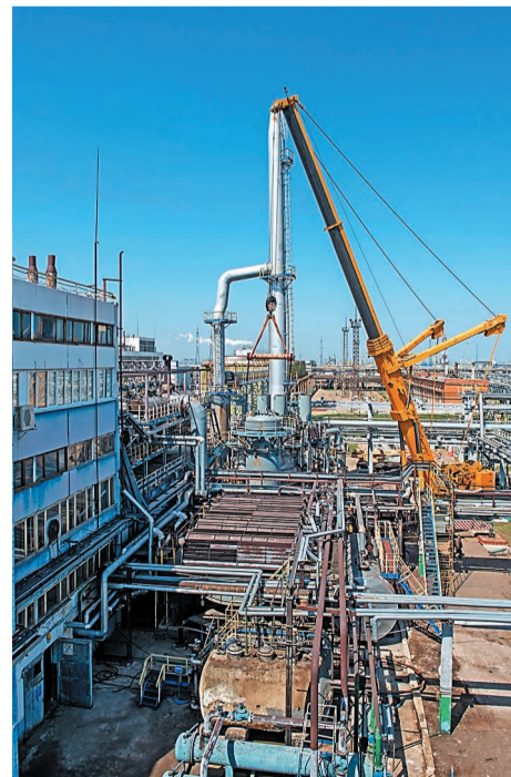
Установка трубного пучка в цехе № 48
