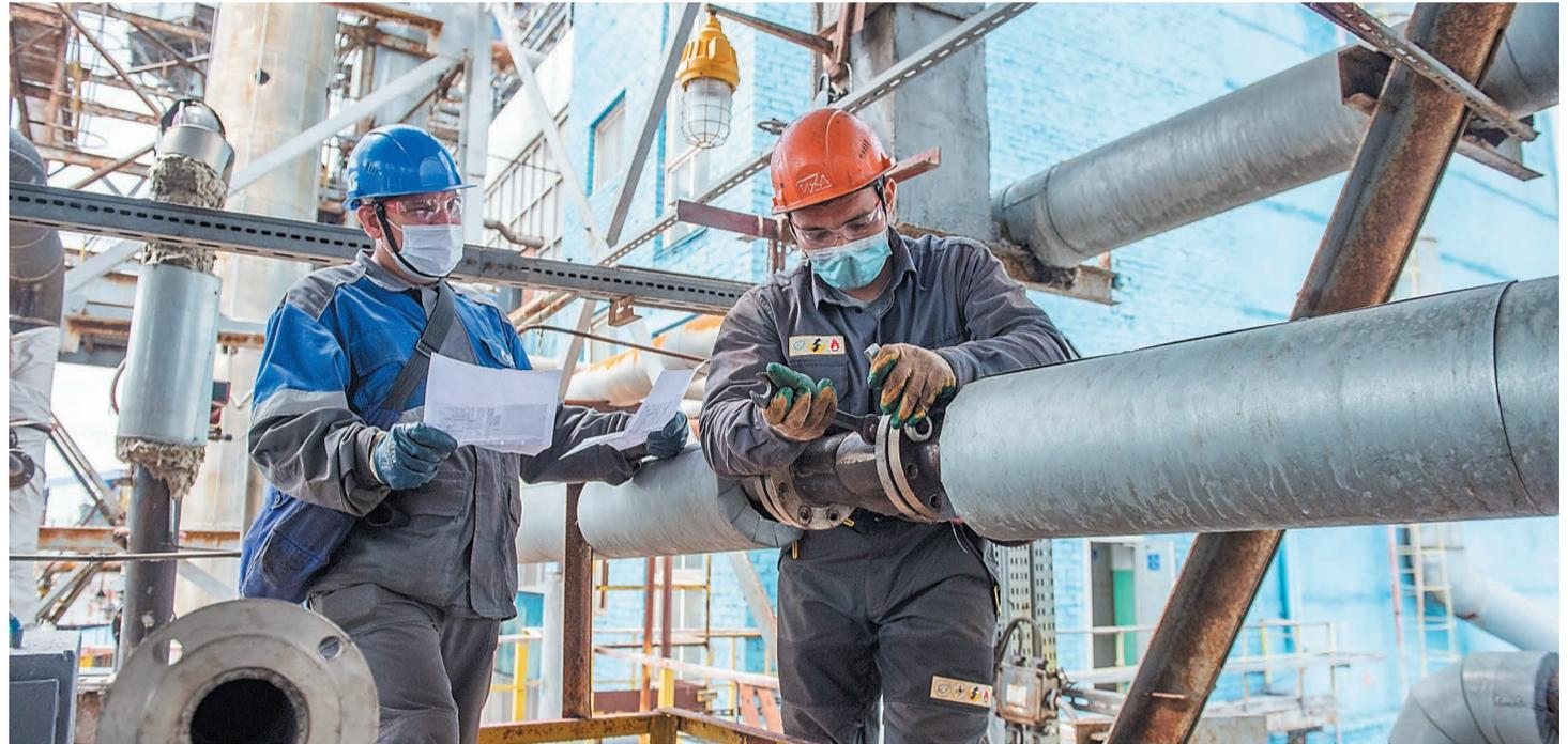
Снятие запорной арматуры с трубопровода газов колонны ректификации в цехе № 50
