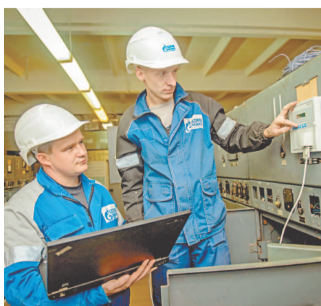
На нефтеперерабатывающем заводе ведется модернизация распределительного устройства
