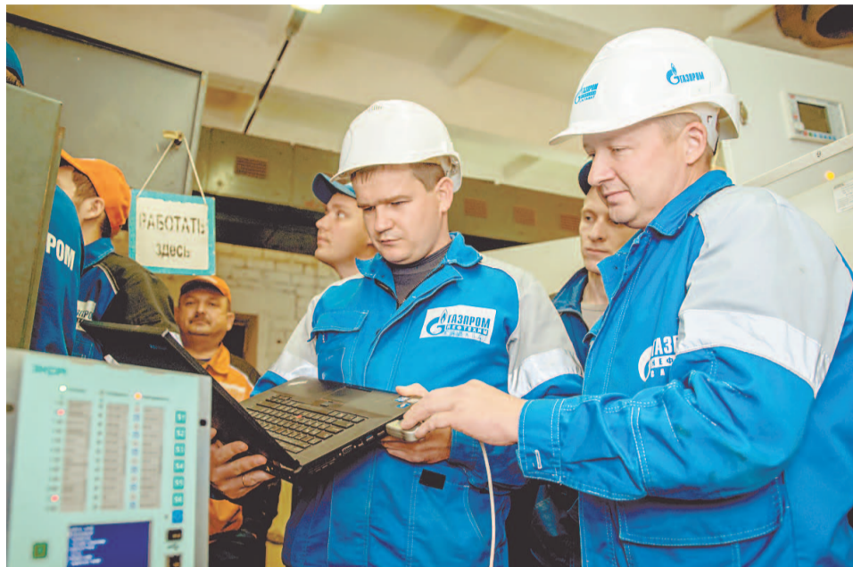
Монтаж нового оборудования сотрудники электротехнической лаборатории выполняют своими силами
