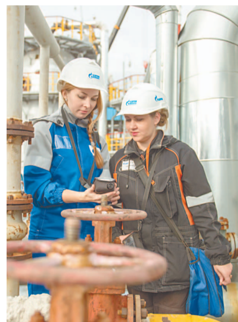
Профилактический обход на ГО-2
