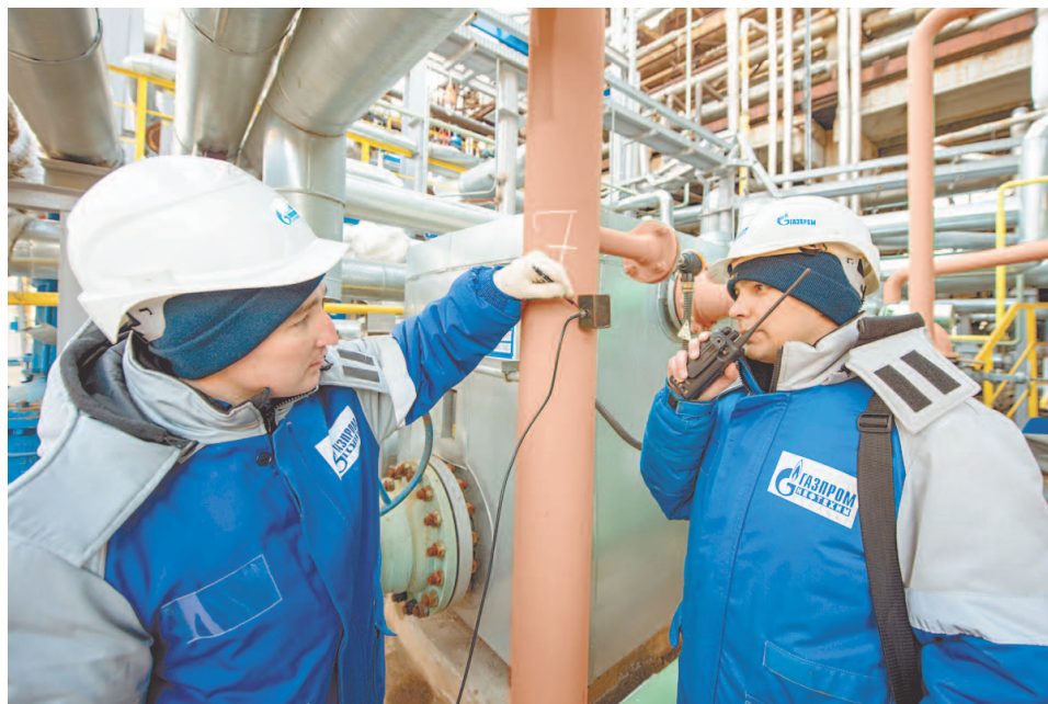
Современное оборудование помогает на ранней стадии выявлять развивающиеся дефекты
