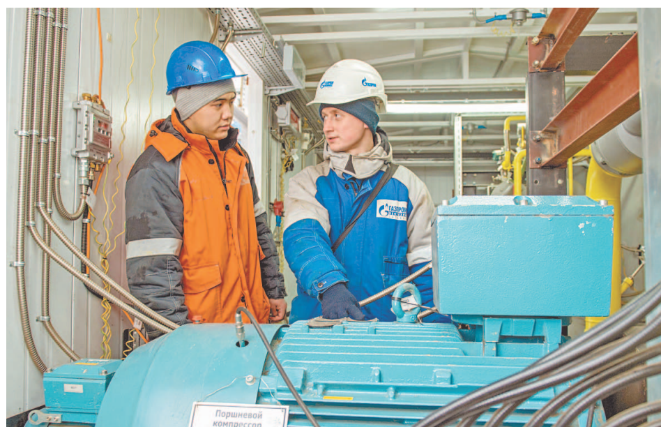
На новой установке СЩС будут происходить процессы флотации, отпаривания, карбонизации, биологической очистки, озонирования
