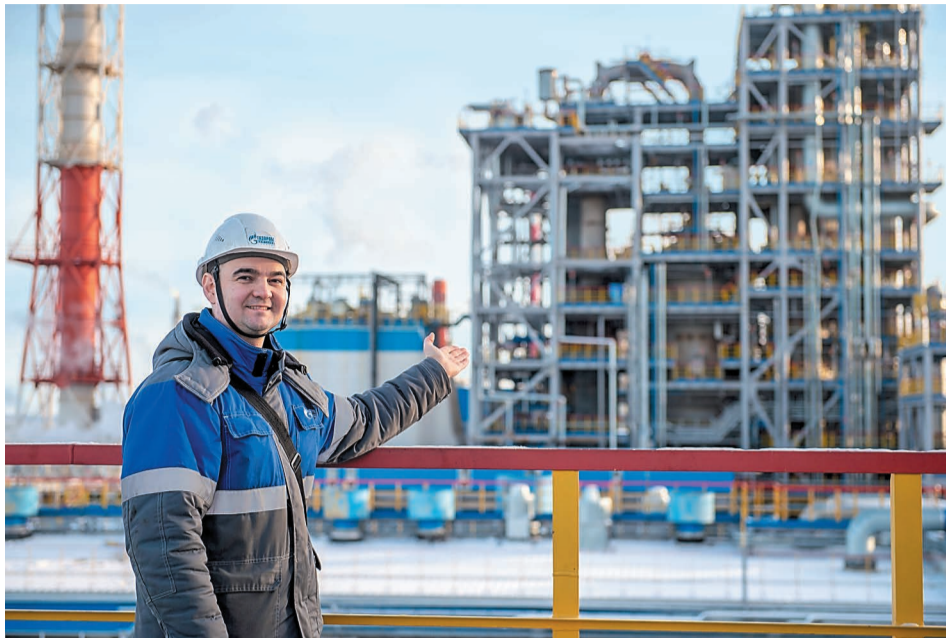
Рим Усманов рассказывает об основном блоке комплекса – реакторно-регенераторном
