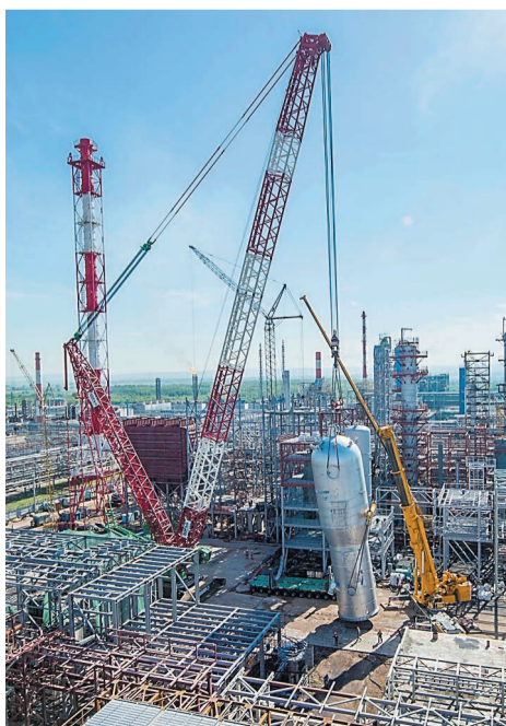
Процесс установки крупнотоннажного оборудования на строящемся комплексе каталитического крекинга в 2016 году
