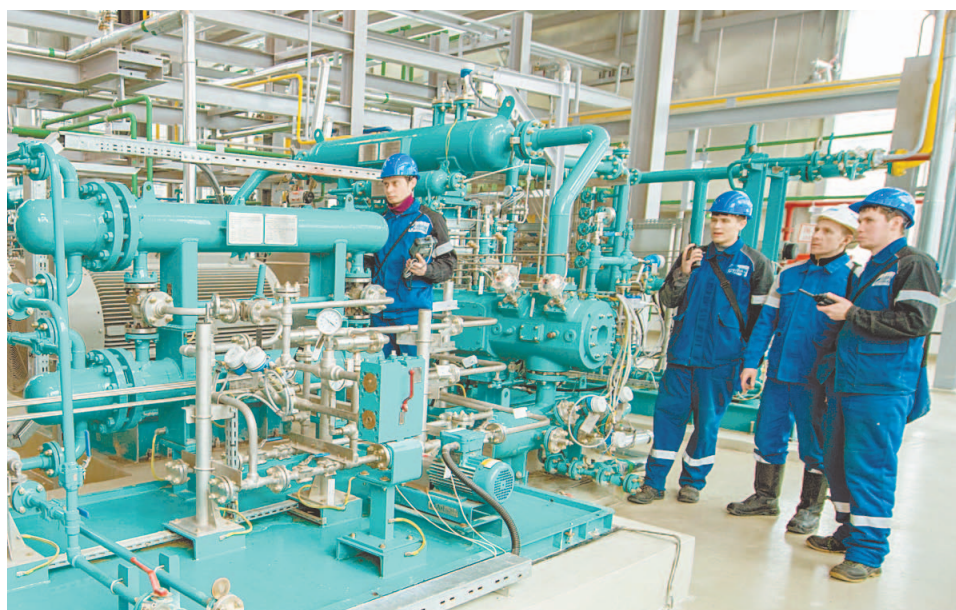
Пуск установки изомеризации позволит увеличить выработку товарных бензинов
