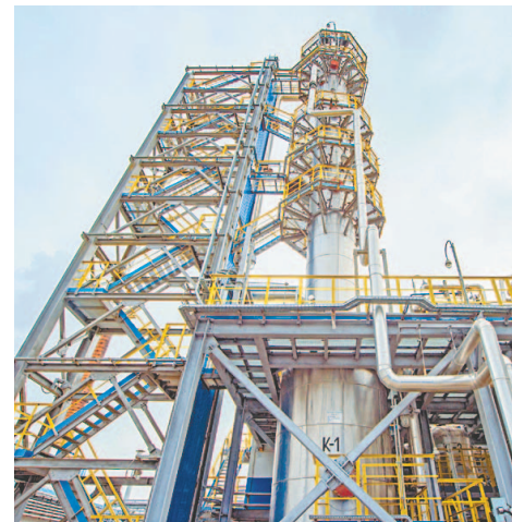
Пуск установки СШС вместе с реконструкцией очистных сооружений позволит сбрасывать в природный объект чистую воду 100%-го качества
