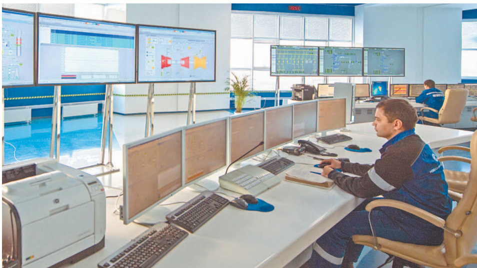
Персонал установки способен вырабатывать 2669,27 млн кВт электроэнергии в год
