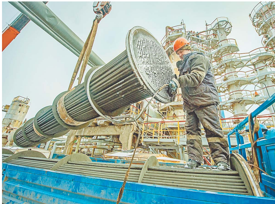
Замена сырьевых теплообменников – одно из важнейших мероприятий ремонтной компании
