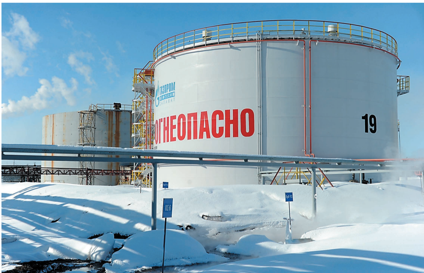
На площадке строятся новые резервуары, отвечающие всем требованиям правил промышленной безопасности
