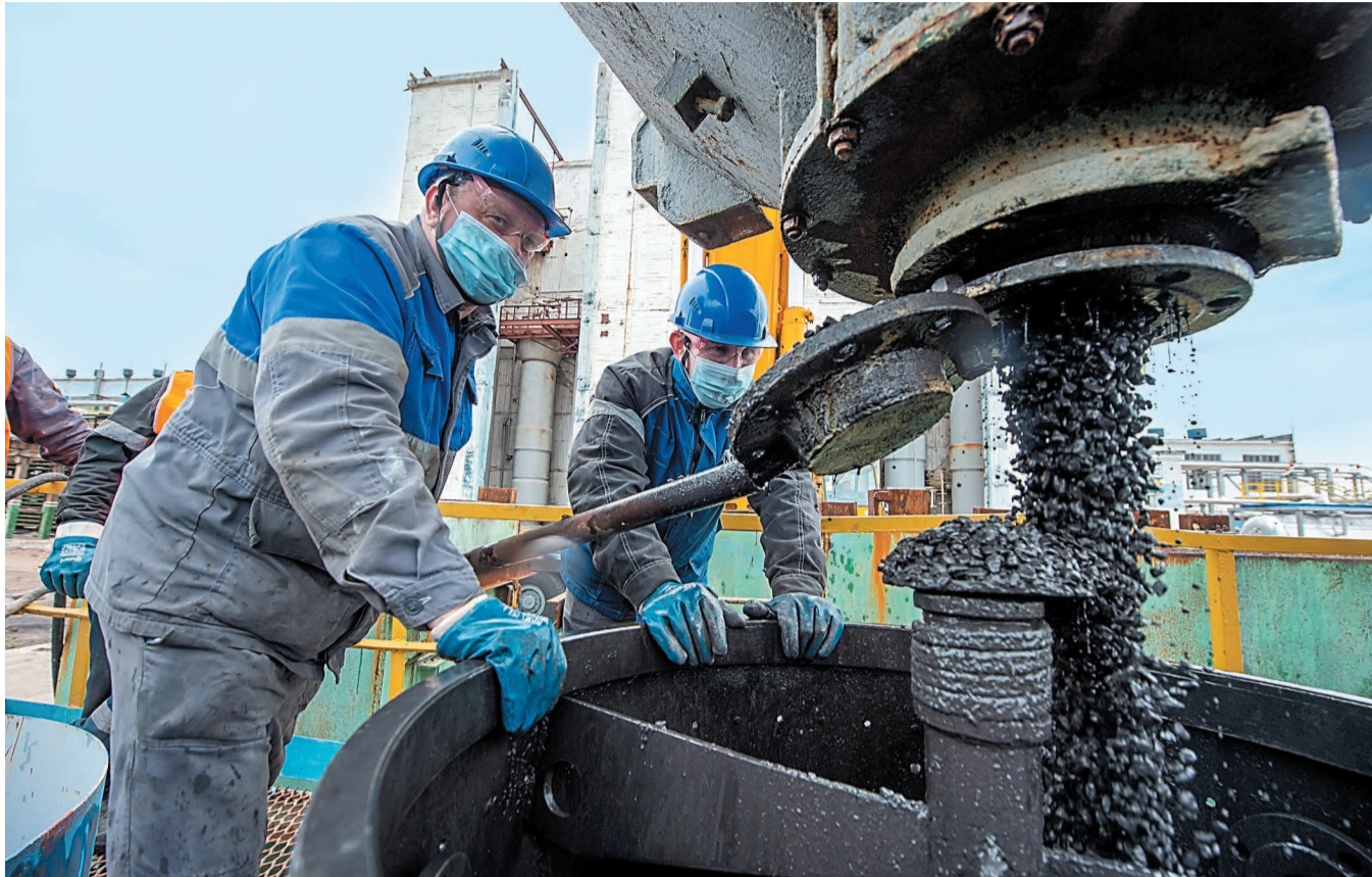
В цехе № 34 идет загрузка катализатора в колонну гидрирования
