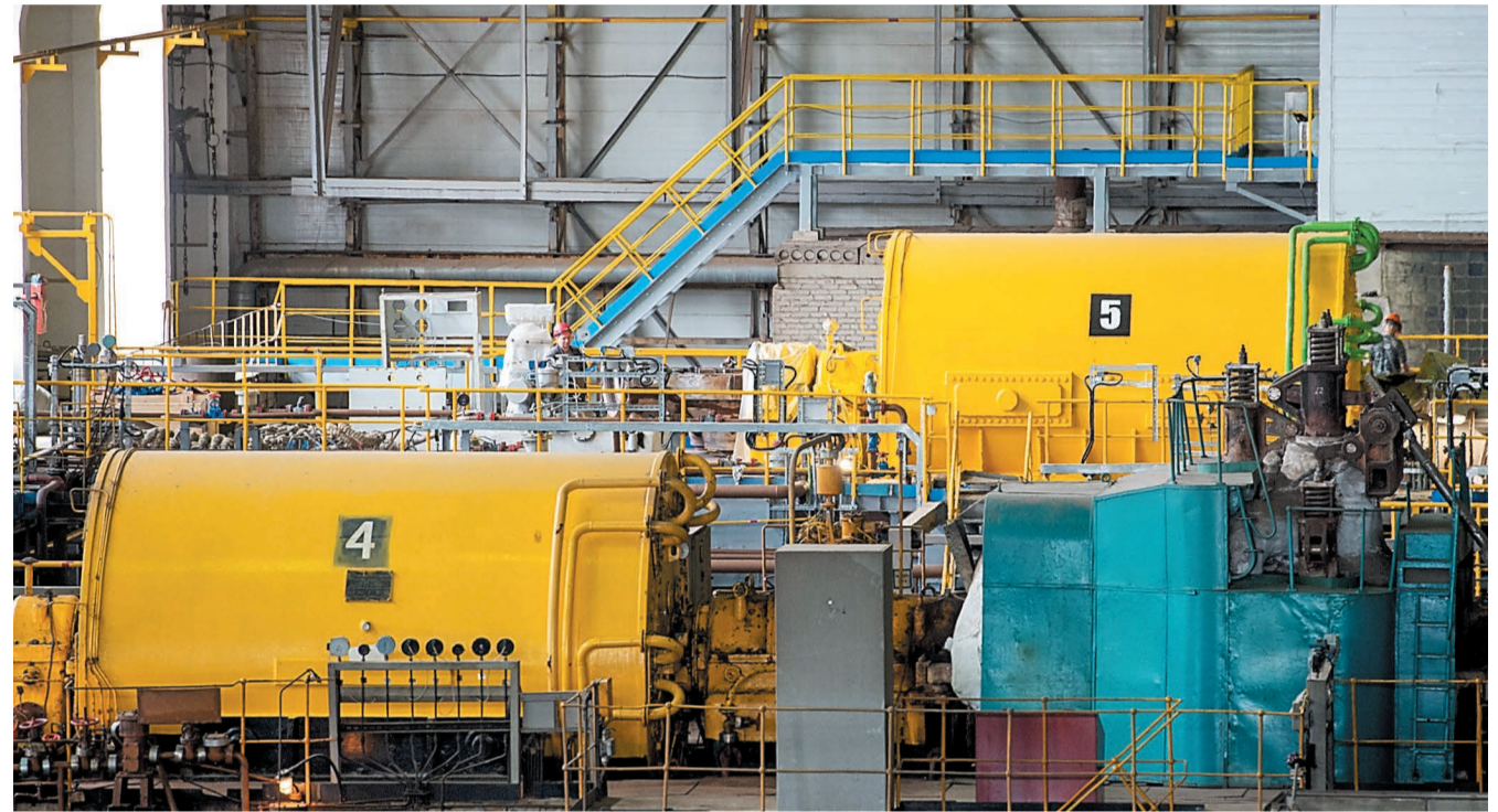
Ведется замена основного и вспомогательного оборудования теплоэлектростанции на более эффективное
