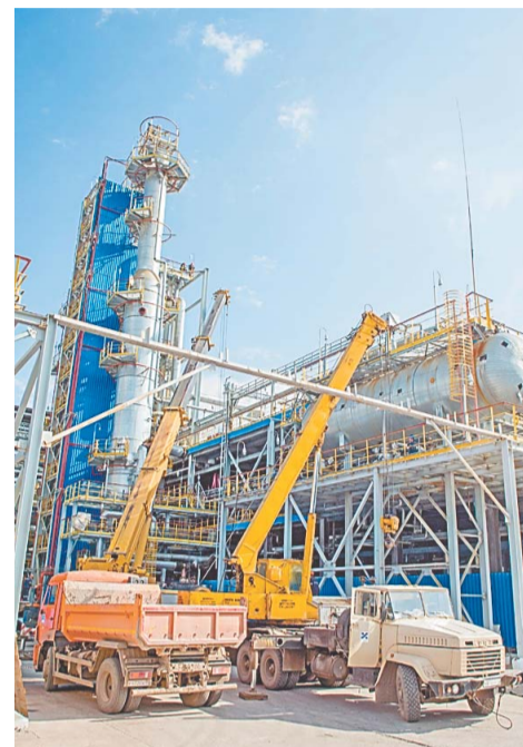
Процесс замены теплообменного оборудования на блоке стабилизации установки ЭЛОУ АВТ-6
