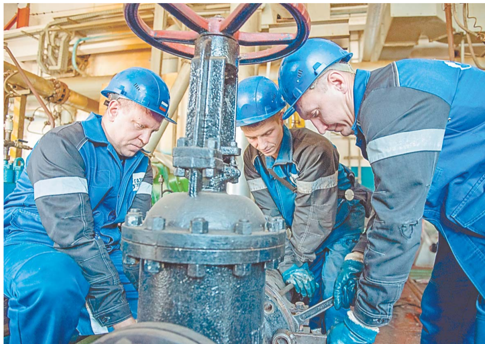
Снятие заглушки для сборки схемы сырьевого насоса на установке ГО-2
