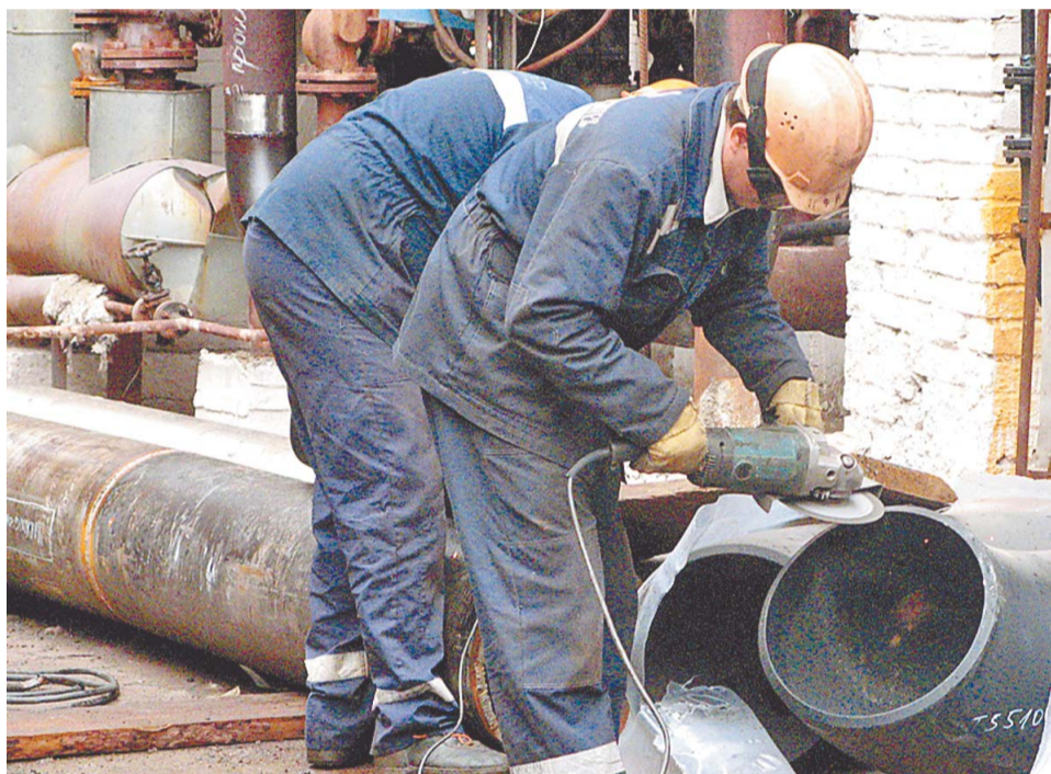
Ремонтники не щадя сил обеспечивали безаварийную работу оборудования
