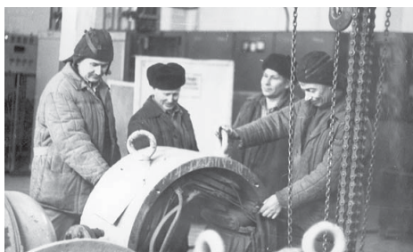
В 1973 году ремонтное производство вводят в штат НПЗ. В его составе трудилось более 500 человек
