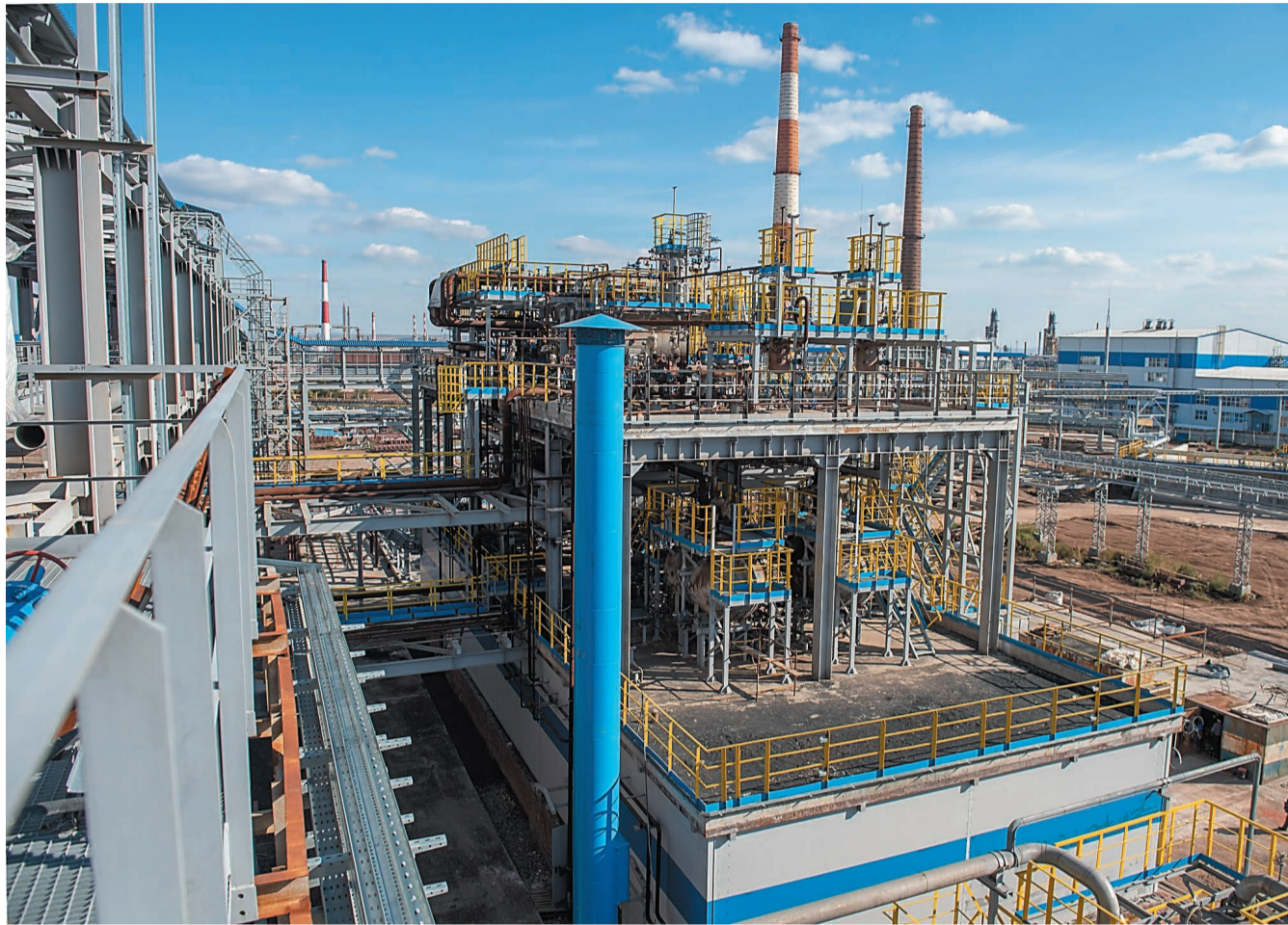
Строится производство технической серы
