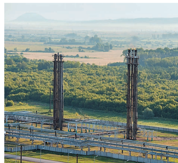
На всех заводах оптимизируется работа факельных систем
