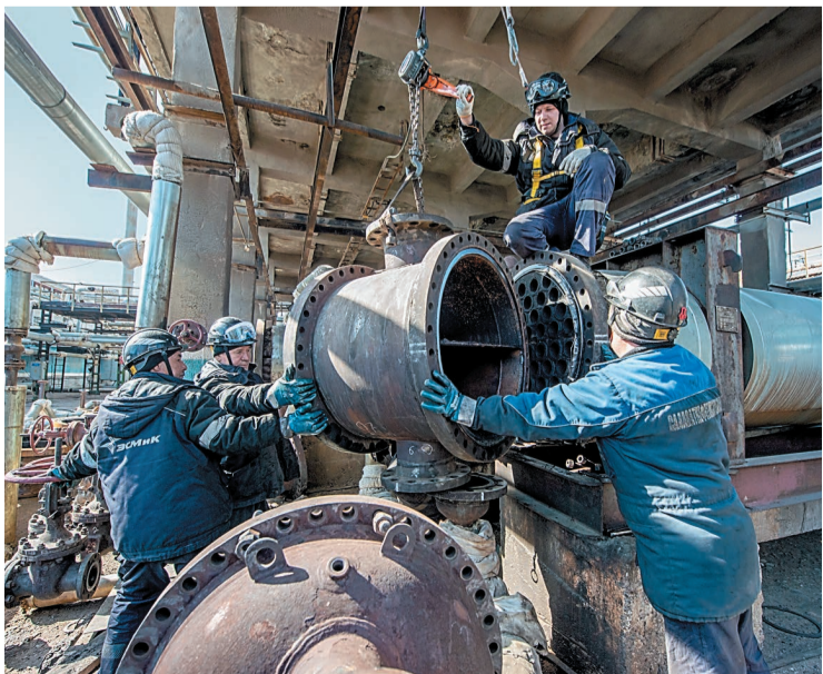
На установках ведется работа по актам отбраковки, устранению дефектов внутренних устройств, чистке теплообменного оборудования
