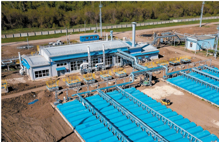
В рамках проекта реконструированы, модернизированы или построены заново объекты, отвечающие за механическую очистку промышленных стоков
