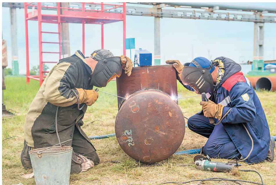
Устранение дефектов на факельном трубопроводе
