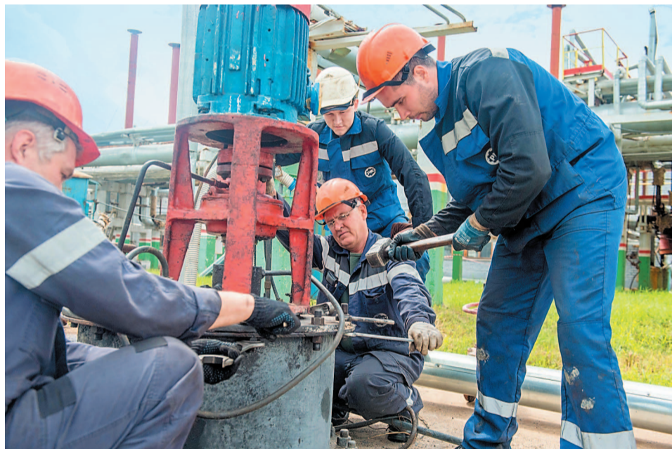
Монтаж насоса Н-5 на емкости Е-9
