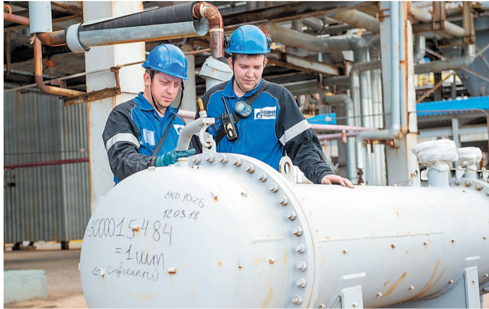
В ходе ремонта были выполнены работы по чистке теплообменного оборудования
