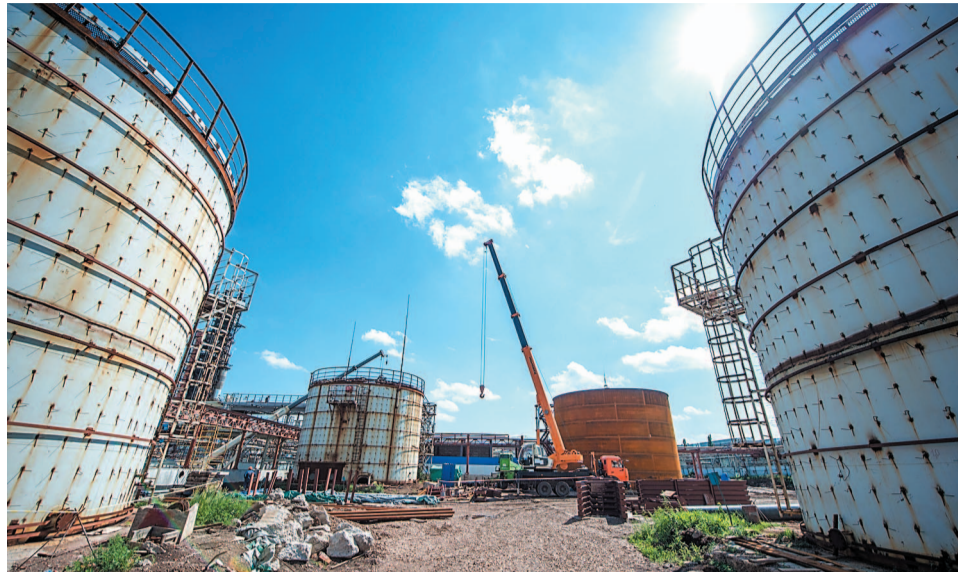
На площадке реконструируют существующие и монтируют новые резервуары
