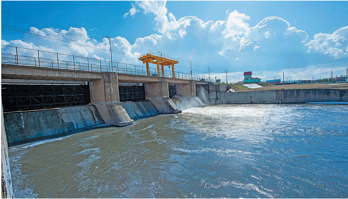
Гидротехнический узел в поселке Нугуш
