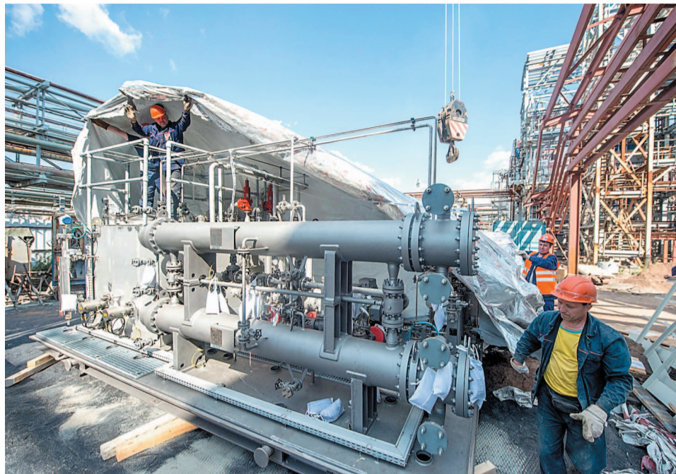
Монтаж маслостанции компрессора жирного газа
