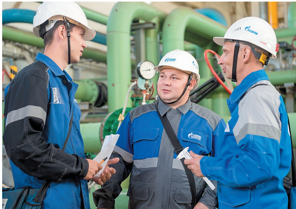
Свой цех № 5 Сергей Логинов называет стратегическим: кислород и азот производится для всех объектов Общества
