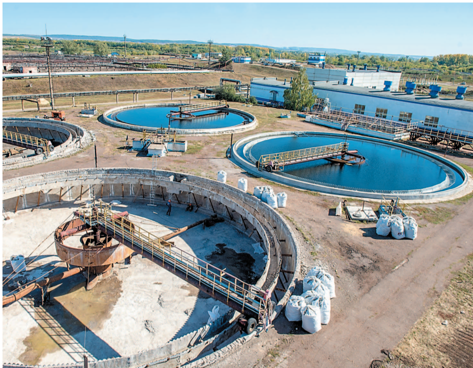
На вторичных радиальных отстойниках ОС-211 отремонтирована запорная арматура обвязки
