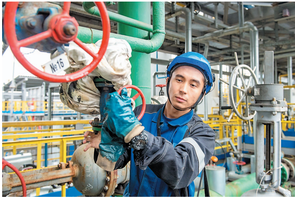
Подготовка линии оборотной воды к осенне-зимнему периоду на установке КЦА НПЗ
