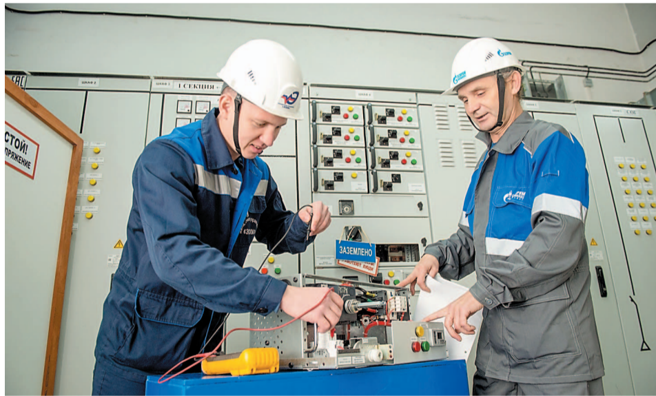
Проверка и наладка цепей управления на выдвижном модуле низковольтного комплектного устройства
