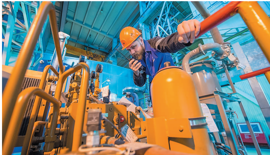
Основные технико-экономические показатели парогазовой установки: 410 МВт электрической энергии, 200 Гкал тепловой энергии (в горячей воде), 2669,27 млн кВт электроэнергии
