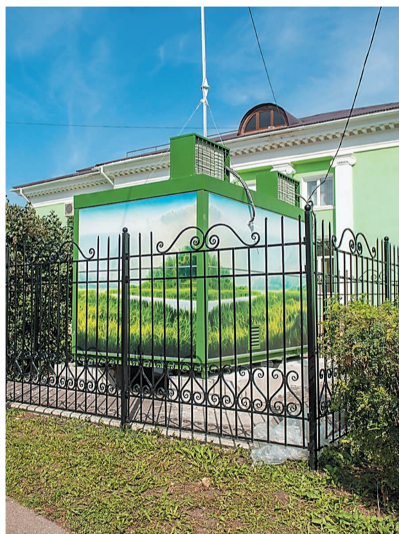
Автоматизированная станция контроля загрязнения атмосферы города Салавата
