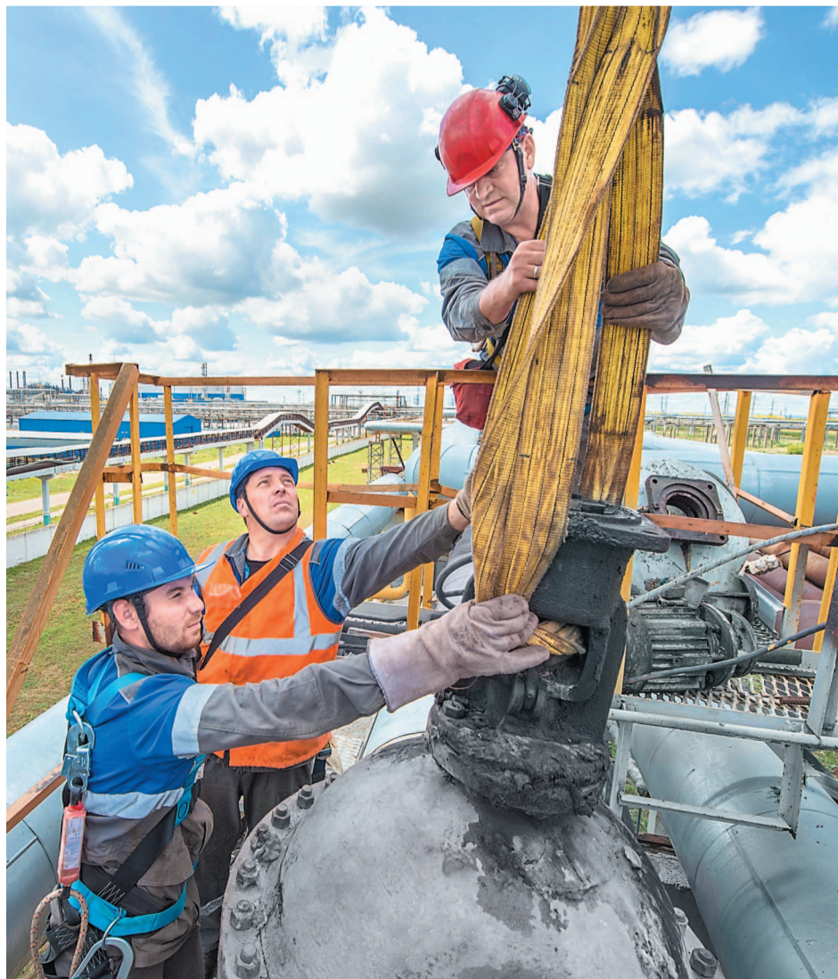
На узле 14/17 идут работы по замене задвижки на трубопроводе пара 7 ата
