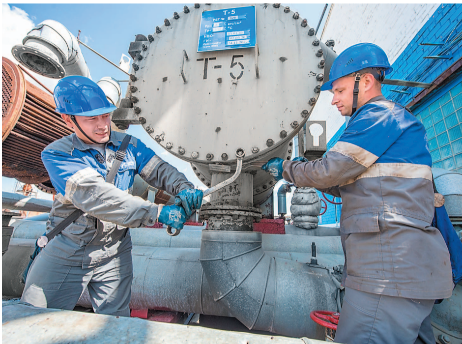
Ведется ремонт по замене запорной арматуры на трубопроводах отопительной воды
