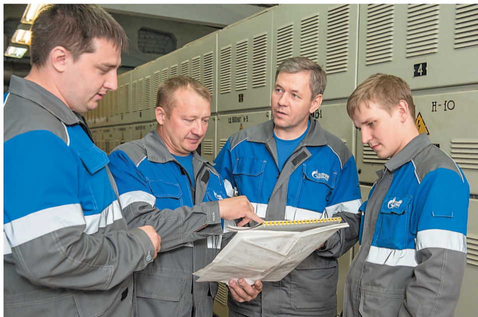
С 2015 года монтаж современных комплексов проводят работники электротехнической лаборатории УГЭ
